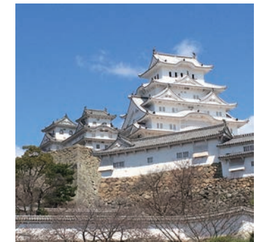
ユネスコ世界遺産・姫路城の瓦を製作している 姫路の日本伝統いぶし瓦の窯元です。
